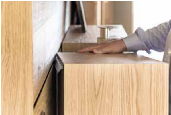
Die Rahmenmöbel werden mit Spezialbeschlägen in Metallschienen eingehängt, die in den Fugen der Möbelwände montiert sind.
